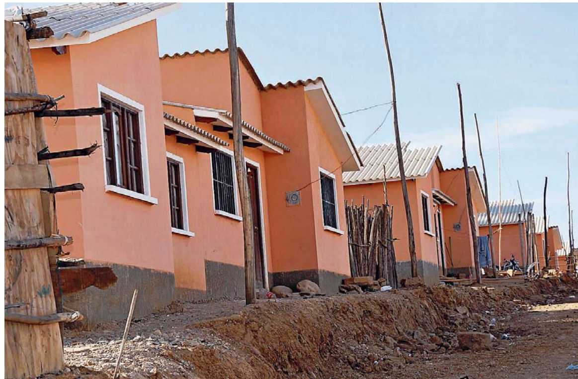
Das Siedlungswerk in Sucre wird zurzeit um 94 Häuser erweitert.
